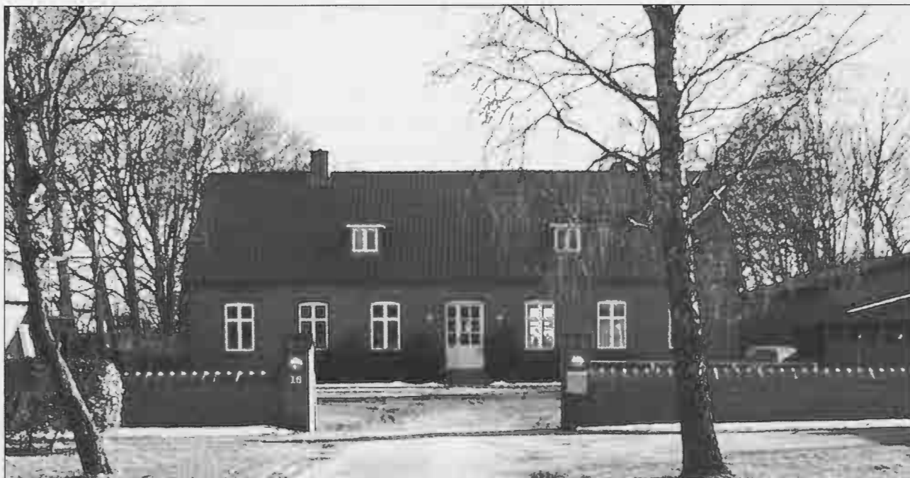
Den gamle præstegård på Øster Hassingvej i Langholt, i midten stuehuset, til højre kostalden, til venstre maskinhuset.
